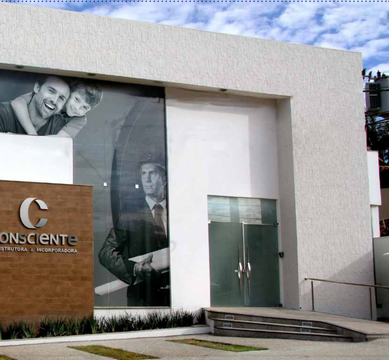
Foto da sede da Consciente Construtora e Incorporadora
