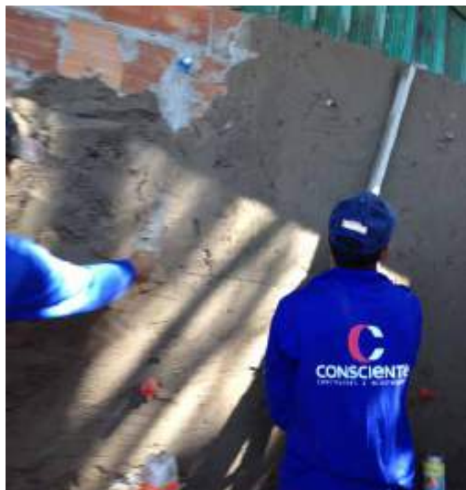
REFORMA DA CRECHE NOSSA SENHORA DE NAZARÉ
